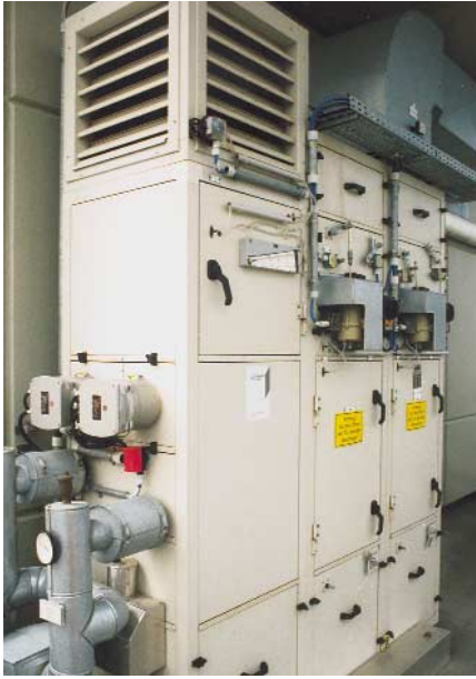
Ex-Kanallufterhitzer 30 kW für Klimaanlage Europipe-Übergabestation Rysum Ex air duct heater 30 kW for HVAC plant Europipe transfer station
